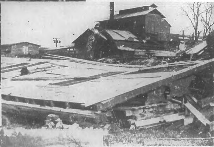
UNA IGLESIA DE ALABAMA EN RUINAS.—La segunda Iglesia Bautista de la ciudad, quedó convertida en este aglomeramiento de ruinas.
